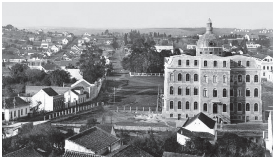
Prédio da Universidade do Paraná em construção. Foto de 1915.
